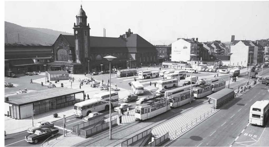
Blick auf den Hauptbahnhof mit der neu gebauten Haltestelle in den Jahren 1960-1961.
