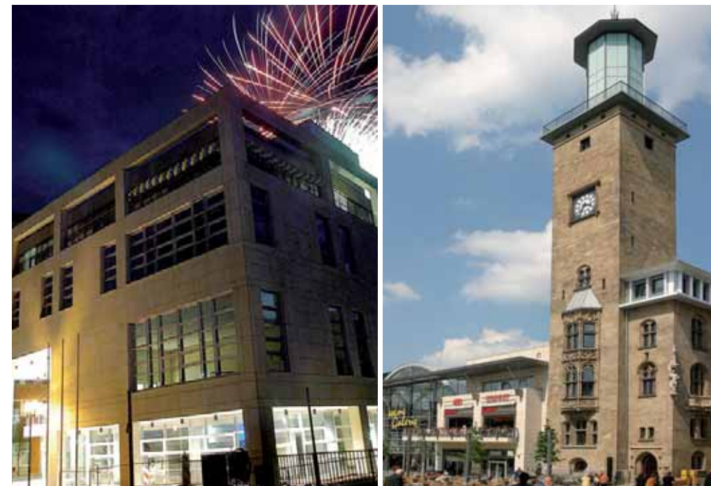
Blick auf das neue Rathaus der Stadt Hagen (links). Historischer Rathausturm (rechts).
