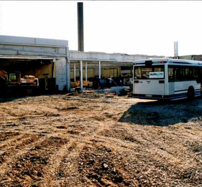
Momentaufnahme während der Umbaumaßnahmen des Betriebshofs Boelerheide.
