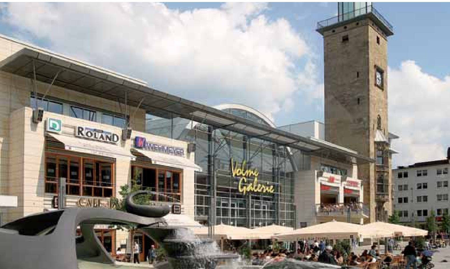
Blick auf die Volme Galerie, die am Friedrich-Ebert Platz in der Hagener Innenstadt gebaut wurde.
